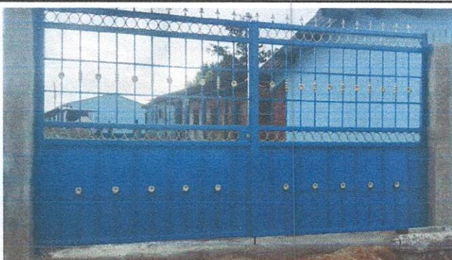
Foto 3: Sustitución de portón
