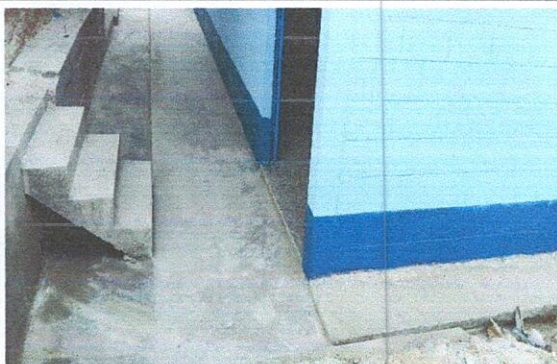
Foto 9: sustitución de cuneta
