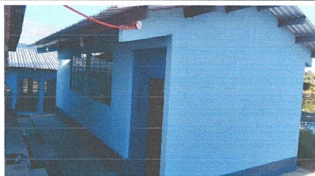
Foto 2: Sustitución techo de cocina
